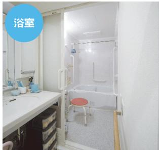
車イスに乗ったままで浴室内に入れるよう、入り口は3枚引き戸にしています。床も段差のないフラットタイプです。浴槽も跨ぎやすい低床式に。滑りやすい浴室での事故を防ぐため、体をしっかりと支えてくれる手すりを3方の壁に設置しています。
